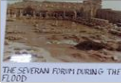
الصورة (8) تدفق مياه الفيضان داخل الميدان السيفيري
